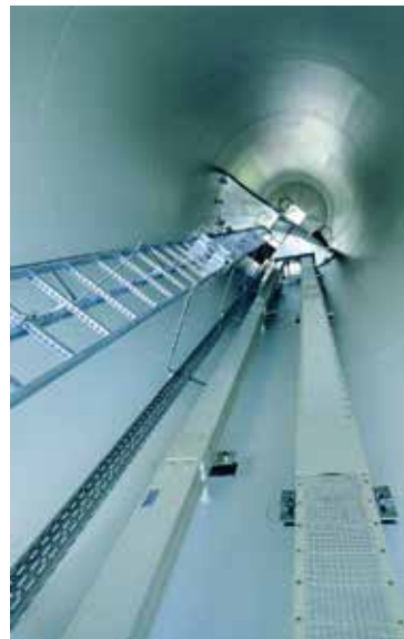
图2：专为风力发电行业而设计的LDA母线系统适用于塔筒内发电机定子和转子的输出回路，设计先进，环保，安全可靠。
