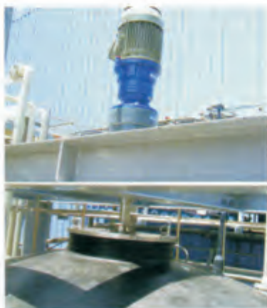
化工儲槽（格南軸封）
